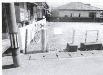
設置し直された政所の道標 (永源山南口駐車場)
