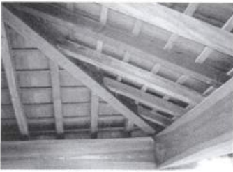
縁側天井部分
