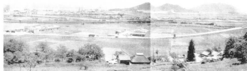
昭和 38 年 (1963) 6 月 14 日撮影 中間作アパート建設予定地 (後の田園調布自治会) 界限
