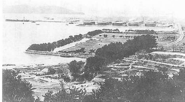
写真4 遠石八幡宮より望む徳山海軍燃料廠
