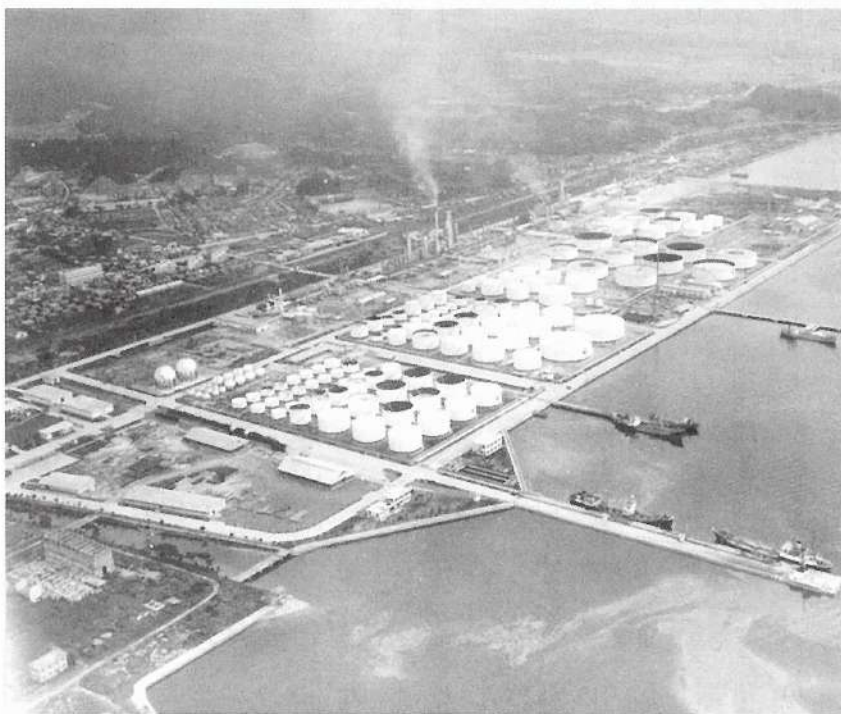
写真7 竣工した出光興産徳山製油所（昭和35年）
